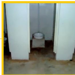
**Figura 3** - Modelo de sanitário com reforço nas estruturas (alvenaria). **“ATENTAR” para que o cano não esteja exposto o que viabiliza a fácil danificação.**
