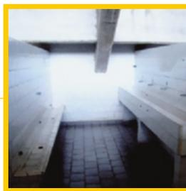
**Figura 6** - Modelo de mictório cujo o sistema de emissão de água dificulta a retirada de equipamentos para uso indevido por parte dos torcedores.
