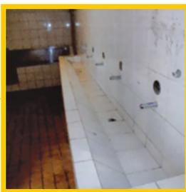
**Figura 5** - Modelo de torneira que dificulta a retirada por parte dos torcedores. **“ATENTAR” para que o cano não esteja exposto, o que viabiliza a fácil danificação.**
